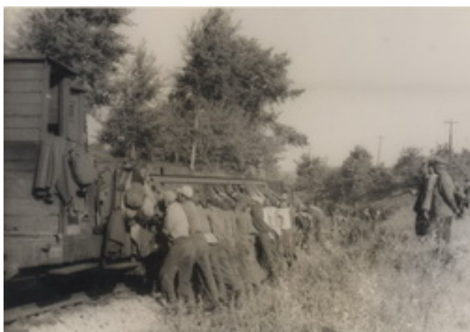
Демонтажа колосека (фото: Јован Павловић)
