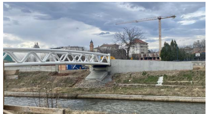
Пешачки мост код базена "Престиж"
